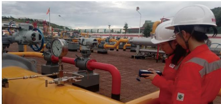
图25：便携式可燃气体检测仪巡检
