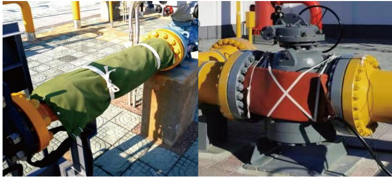
图24：调压工艺试点应用无热源感应加热毯
