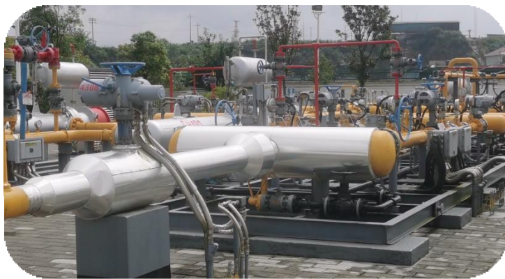
图23：调压工艺电伴热和保温改造
