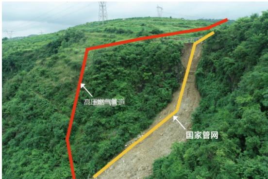
图2 管沟山体全部滑坡现场情况
