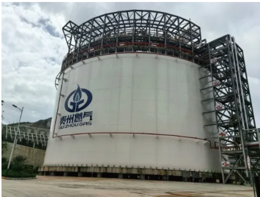
贵阳市天然气储备及应急调峰设施建设项目5万立方米LNG储罐
