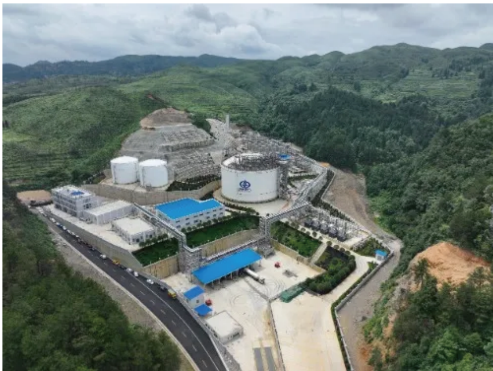
贵阳市天然气储备及应急调峰设施建设项目建成
