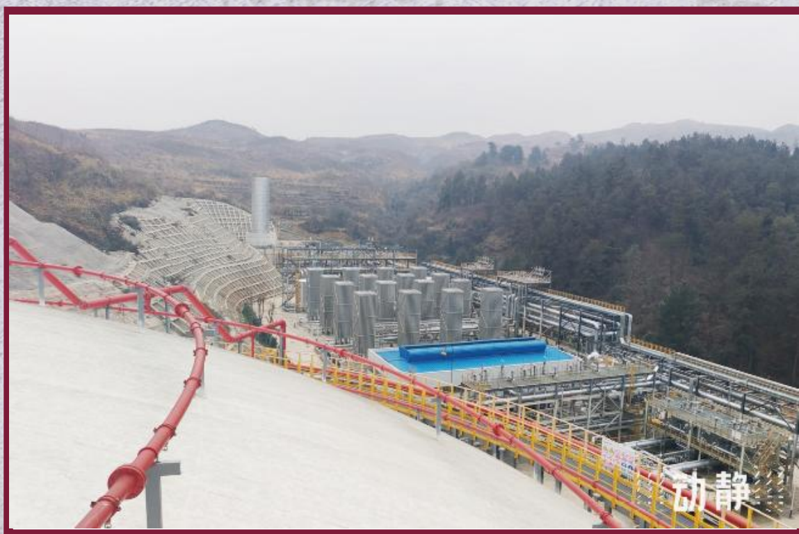
2025年1月贵阳LNG应急调峰站（花溪）完成 所有设备的单体调试及系统联调联试
