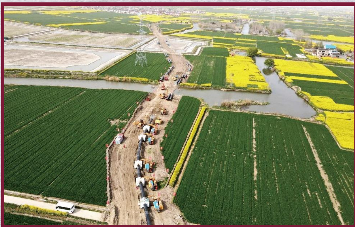
中俄东线天然气管道南段经过华北平原、江南水网， 国家管网集团创新施工技术，建设科技含量高的“绿色管道”
