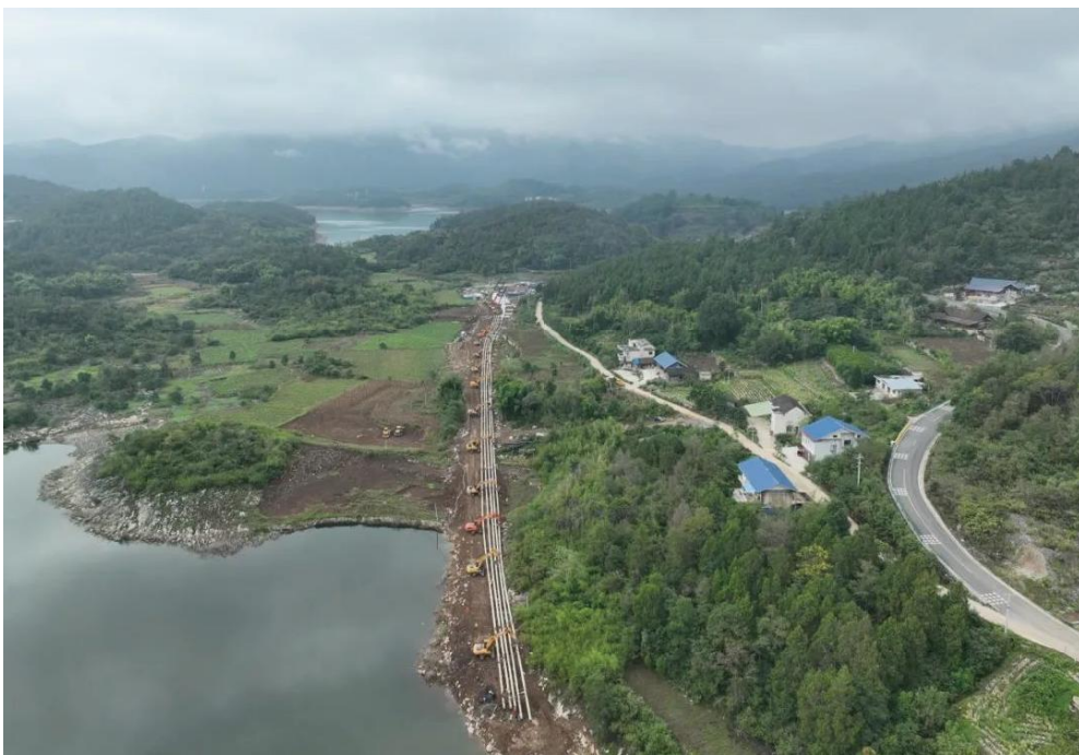
乌江定向钻施工
