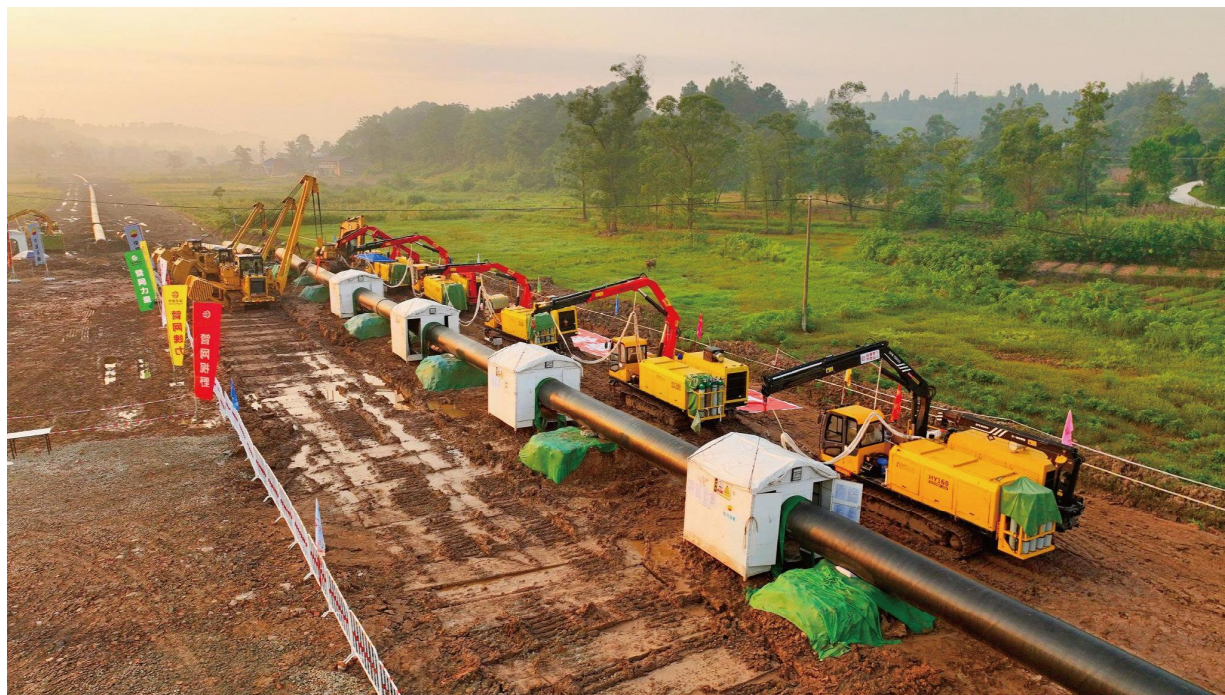
川气东送二线天然气管道东段工程
