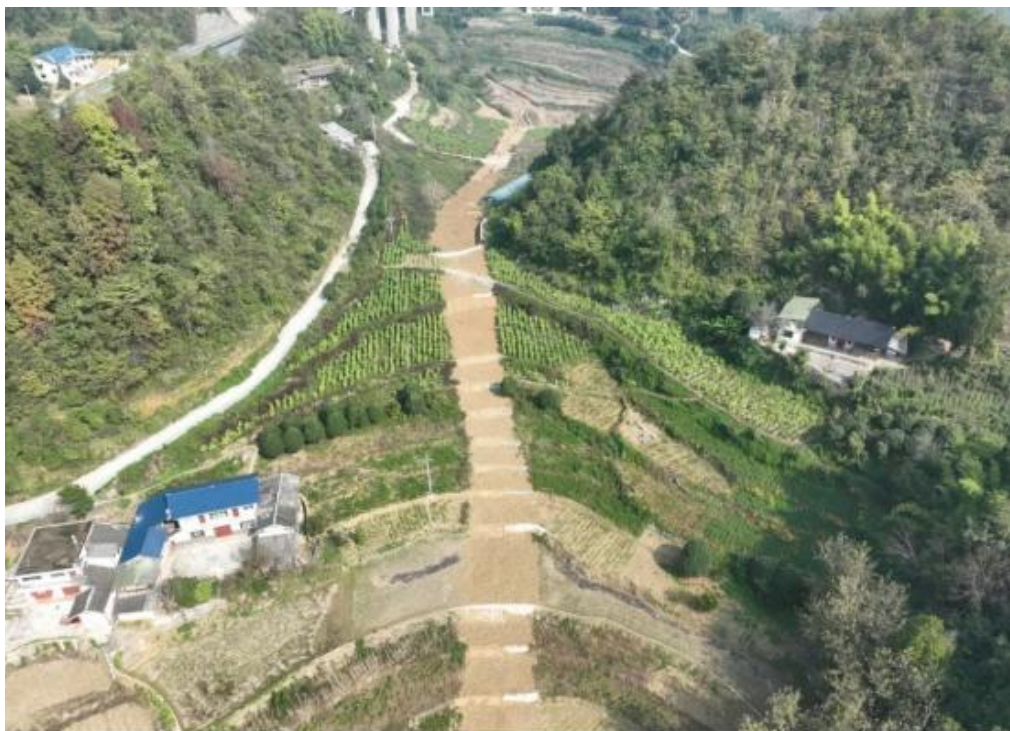
地貌复垦航拍图
