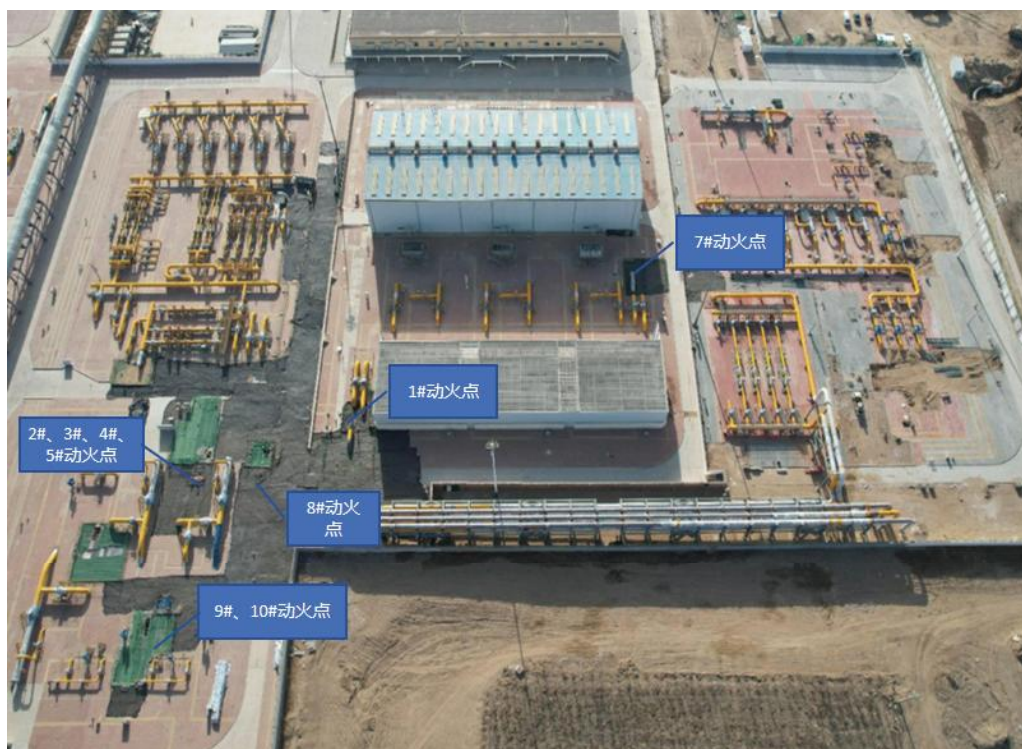
西气东输三线中段10处动火点
