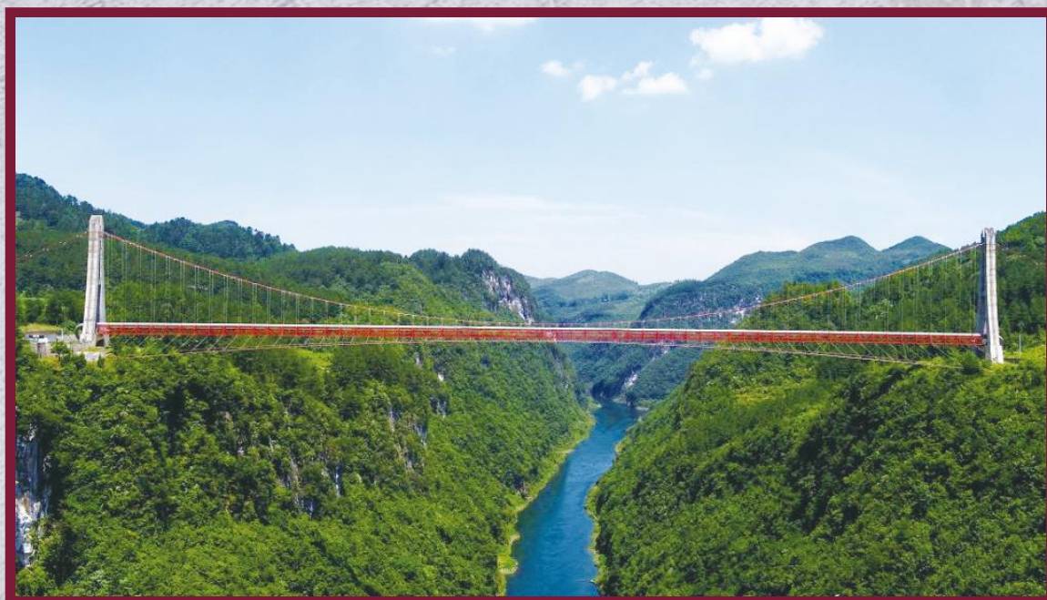
中卫—贵阳输气管道跨越乌江
