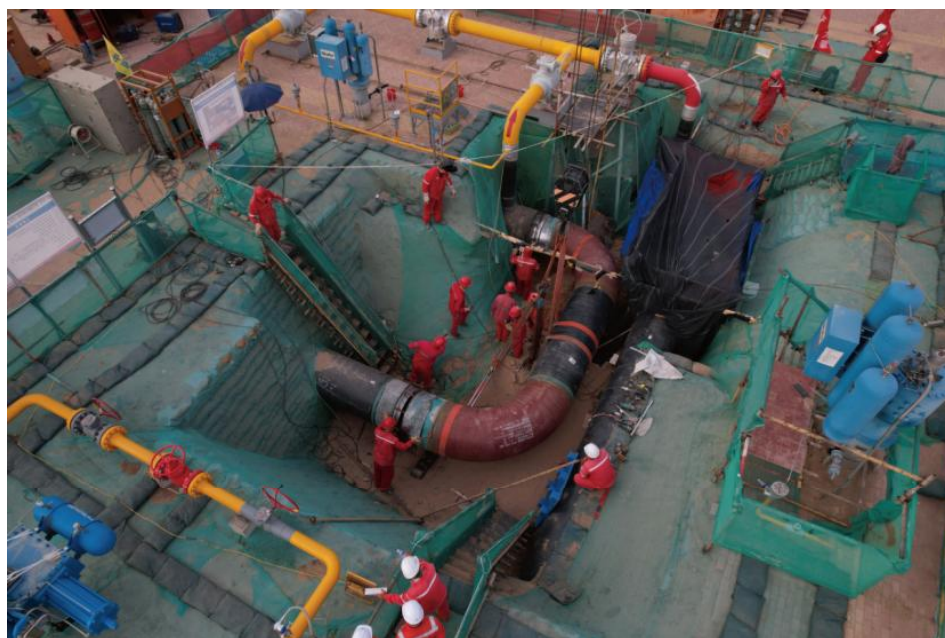
施工作业现场
