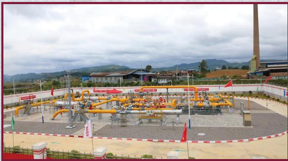
贵定县云雾镇-福泉市天然气支线管道工程云雾首站
