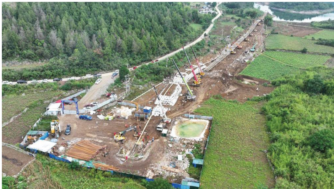
图4 乌江定向钻五接一回拖施工现场
