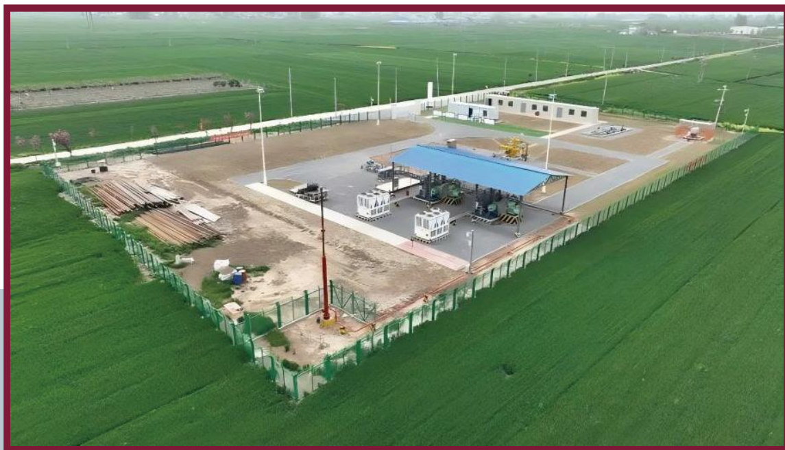
我国首个百万方级盐穴储氢示范工程(河南省平顶山市)航拍图
